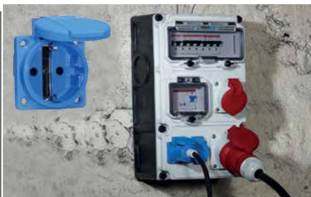
Nástěnný rozváděč VARIABOX se zásuvkou s ochranným kontaktem IP54 pro stacionární rozváděče
